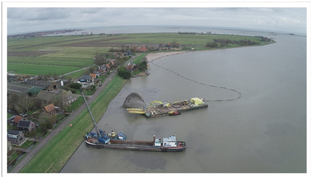
Werkzaamheden polder Katwoude
